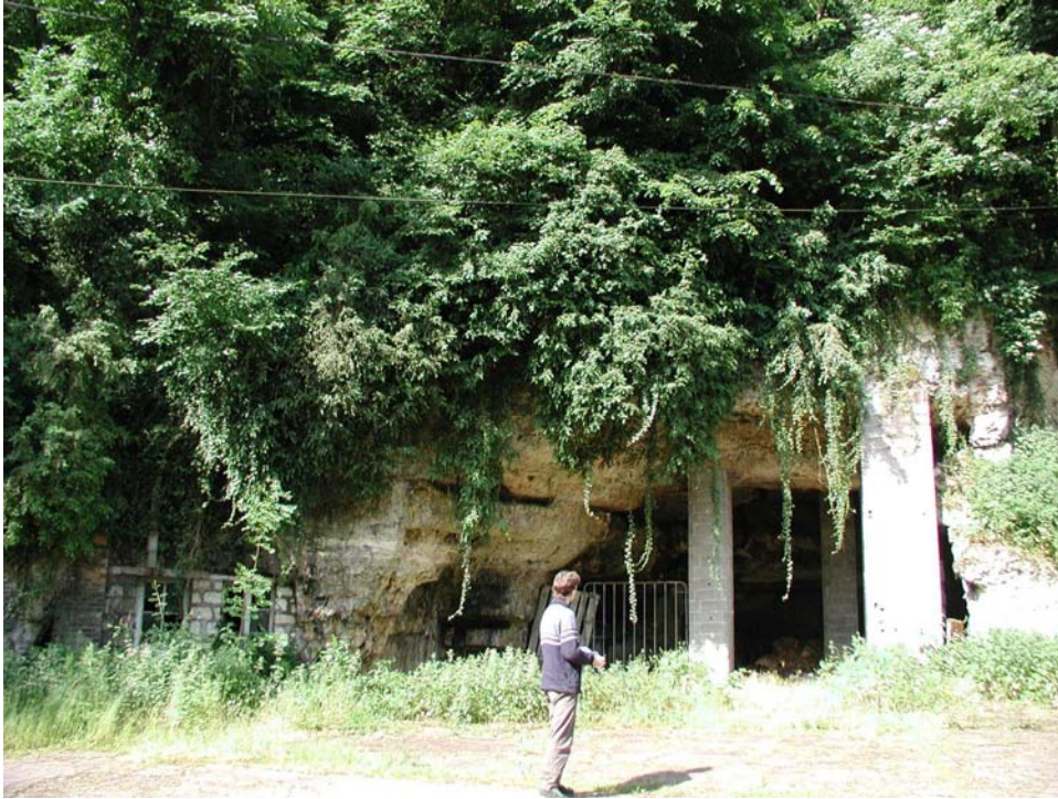
Illustration 14 - Habitation troglodytique confortée à Marboué.
